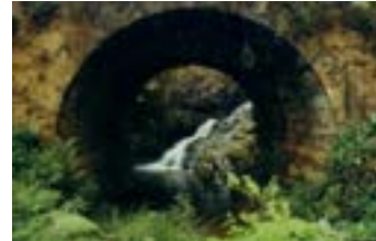
Ponte na Rancharia
